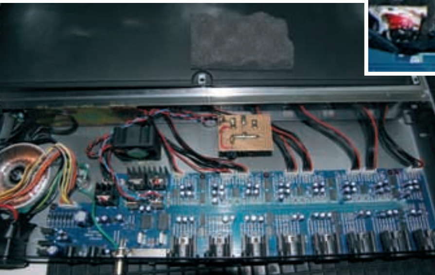
Bild 5: Das sieht gut aus – sauber eingebaut und auf Funktion geprüft
