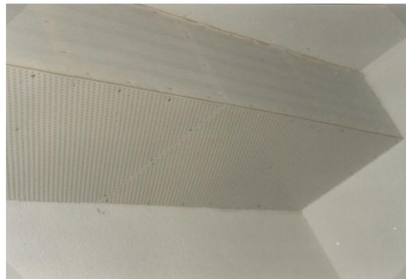
Bild 11 und 12: An der Stirnseite des Raumes ein großer Kastenabsorber als Bassfalle montiert
