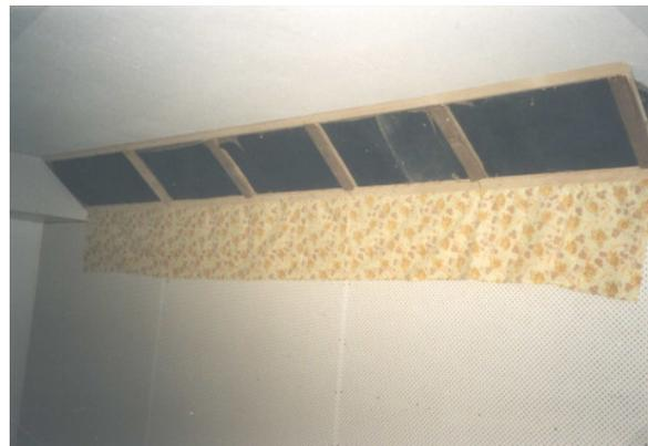
Bild 13: An den Längsseiten wurden Teilflächen der Wände mit 60mm dicken Breitbandabsorbern belegt und an der Decke abgeschrägte Tiefenabsorber montiert.
