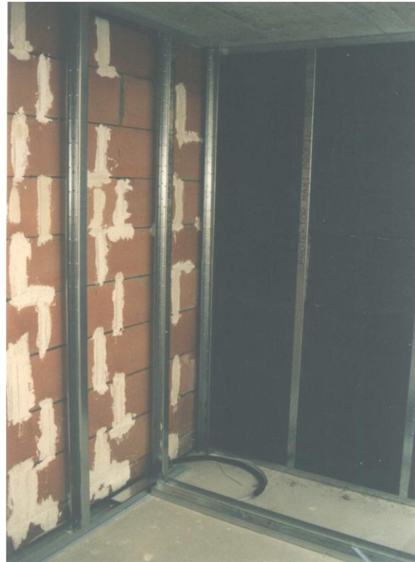
Bild 5: Vorsatzschale an den Wänden
